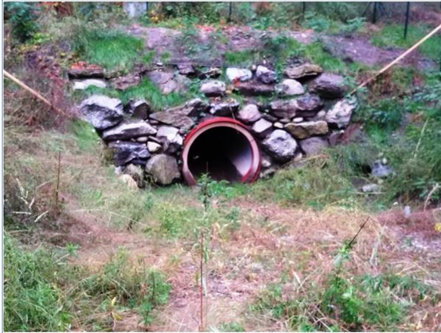
Figura 16 - Accesso sud alla struttura di attraversamento realizzata presso il varco V30.
