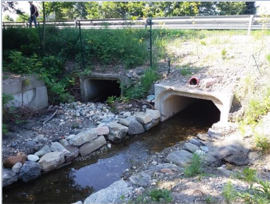
Figura 21 - Accesso est alla struttura di attraversamento realizzata presso il varco V50.
