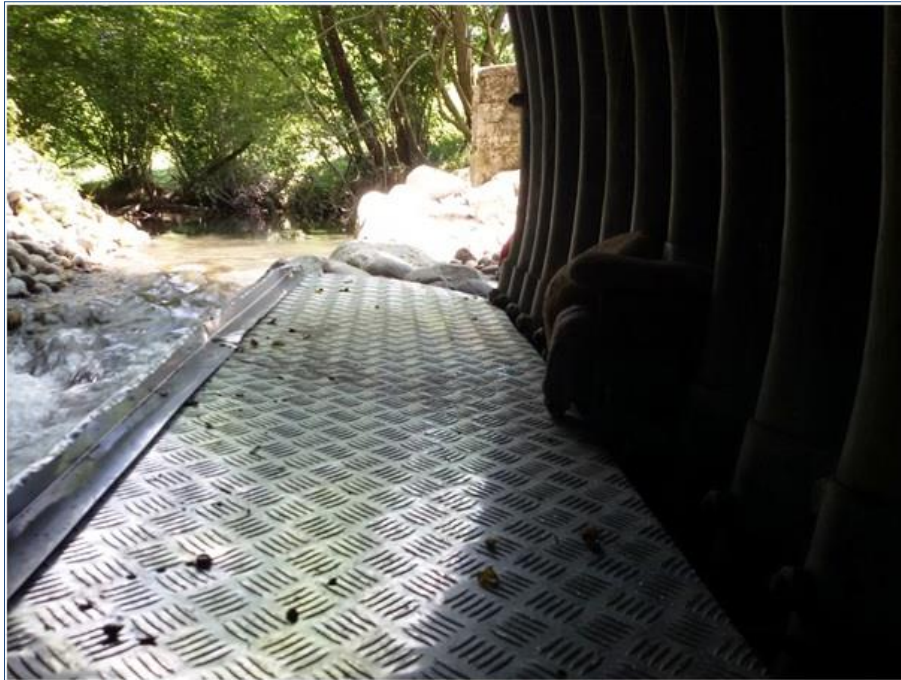
Figura 43 - Particolare della passerella realizzata in sponda sinistra lungo il torrente Acqua Nera presso il varco V11.
