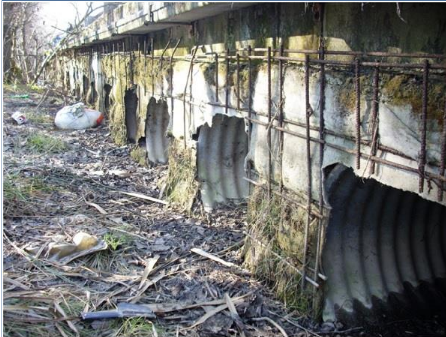
Figura 30 - Apertura degli accessi per rimozione delle griglie metalliche presso lato sud del varco V43.
