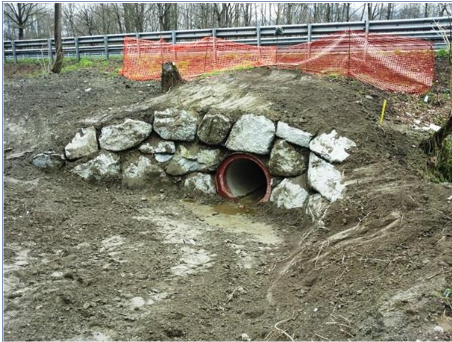
Figura 9 - Accesso ovest alla struttura di attraversamento realizzata presso il varco V22 (foto scattata prima della conclusione dei lavori).
