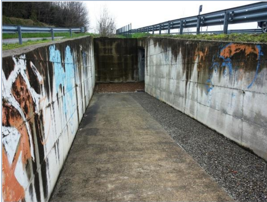
Figura 34 - Accesso nord-est alla struttura di attraversamento adattata presso il varco V49.
