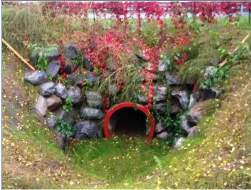
Figura 13 - Accesso sud alla struttura di attraversamento realizzata presso il varco V28.
