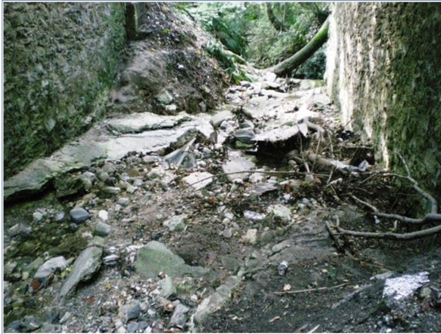
Figura 39 - Accesso nord alla struttura di attraversamento adattata presso il varco V02.
