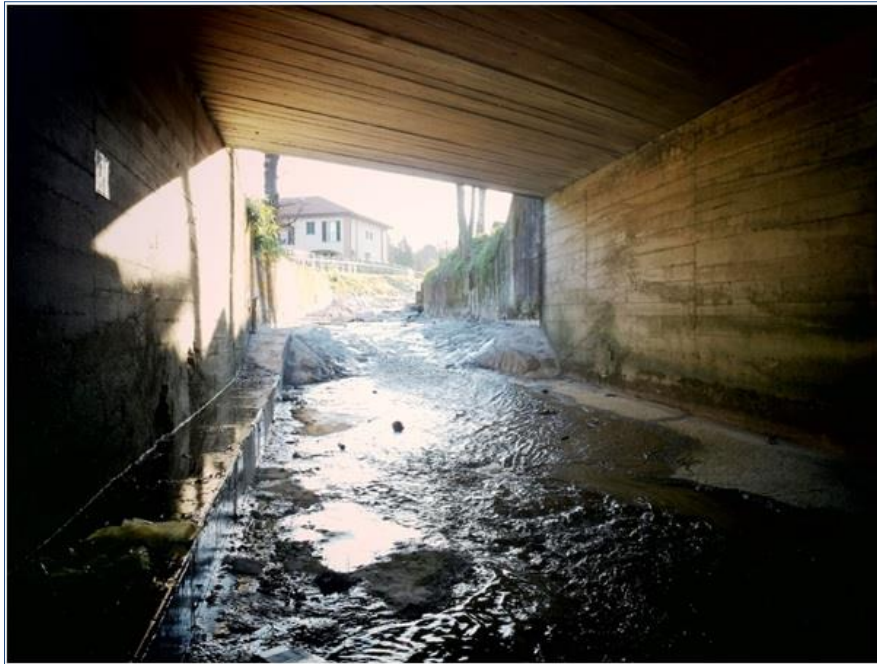
Figura 54 - Particolare della passerella realizzata in sponda destra lungo il torrente Valleluna presso il varco V54.
