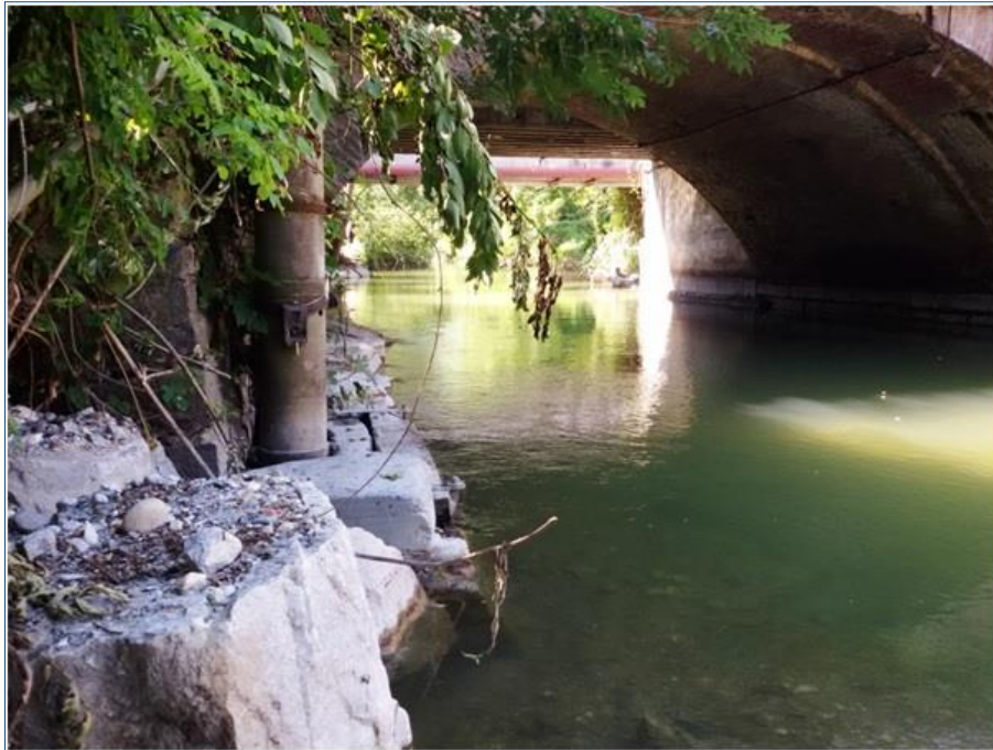
Figura 46 - Particolare della passerella realizzata in sponda destra lungo il fiume Bardello presso il varco V40.
