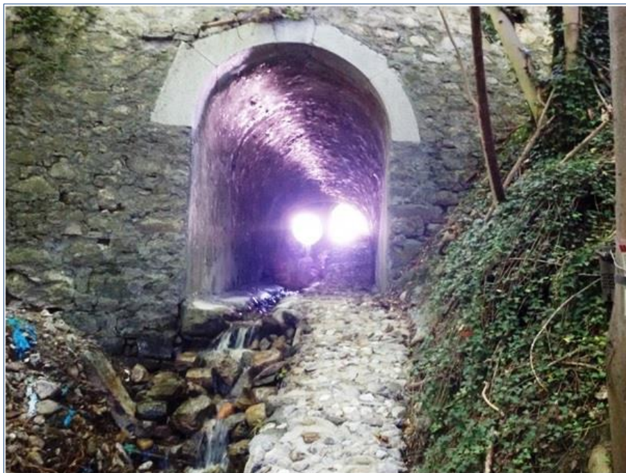
Figura 50 - Particolare della passerella realizzata in sponda destra lungo il corso d'acqua appartenente al reticolo idrico minore presso il varco V48.
