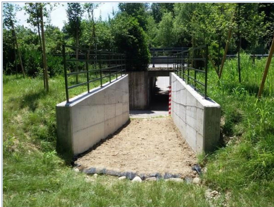
Figura 27 - Accesso nord alla struttura di attraversamento realizzata presso il varco V37.
